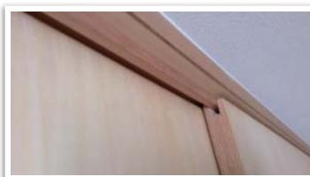
建具又は建具枠に変形、腐食等の現象が生じ、開閉不良、がたつき等による機能低下
